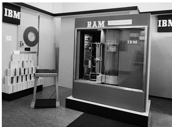
L'IBM 350 fut le premier ordinateur à disque dur commercialisé en septembre 1956 par IBM. Son prix était à l'époque de 50 000 $ US.
